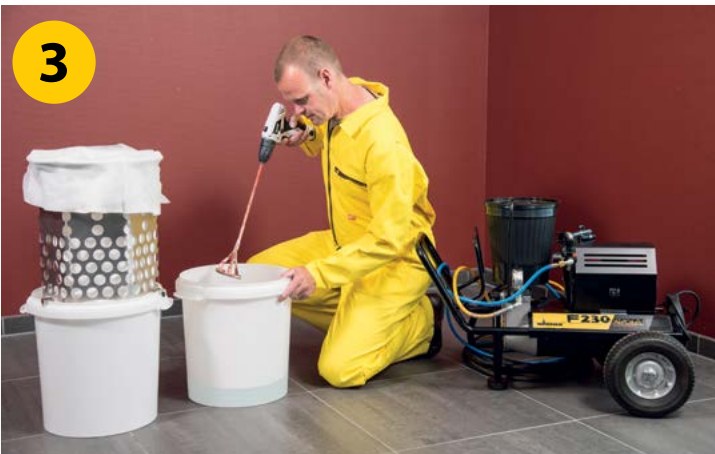
3 Met een spindel wordt het geheel opgeroerd.
